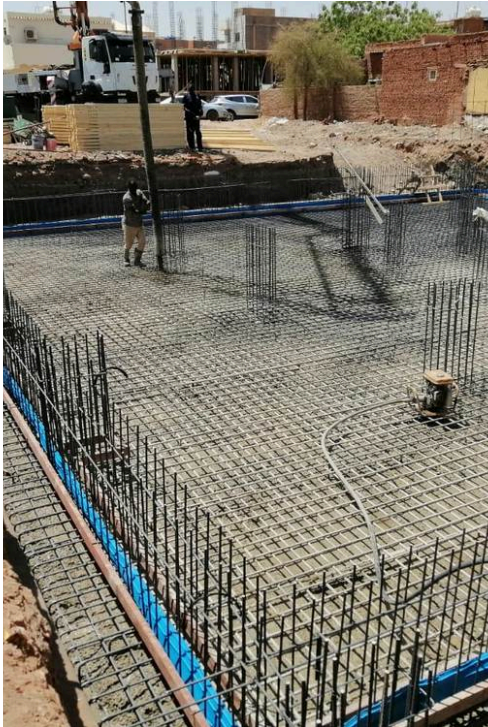
Foundation pour with concrete pump
