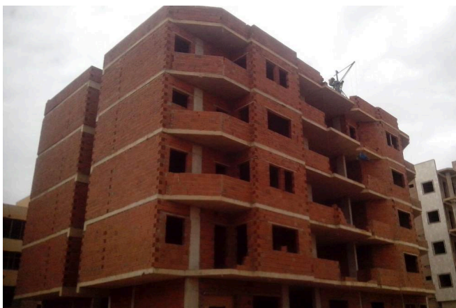
اكتمال الهيكل الخرساني وأعمال المبانى بالطوب
