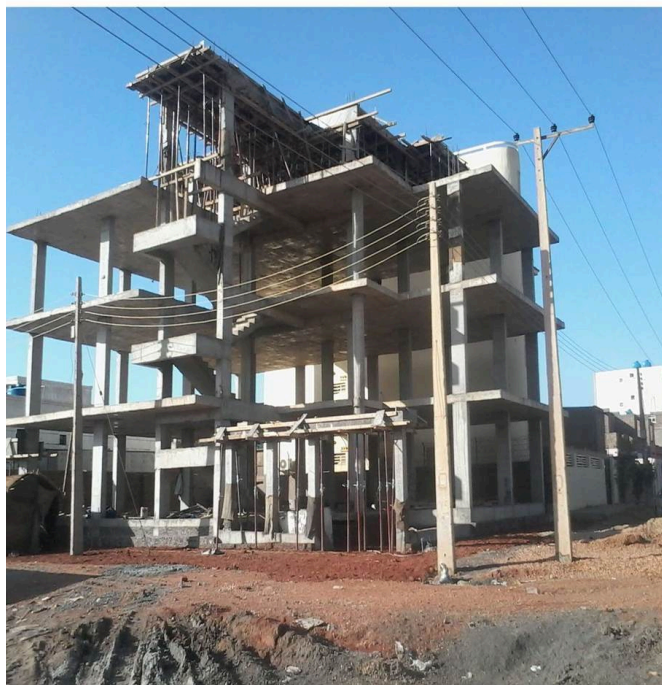
الهيكل الخرساني أثناء التنفيذ
