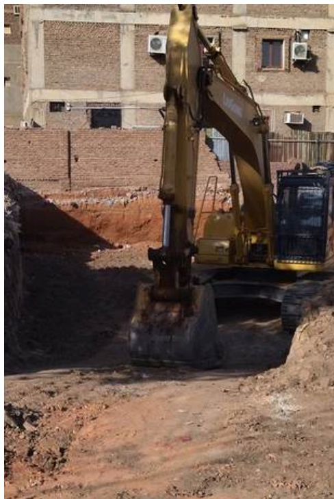
أعمال الحفر والتأسيس
