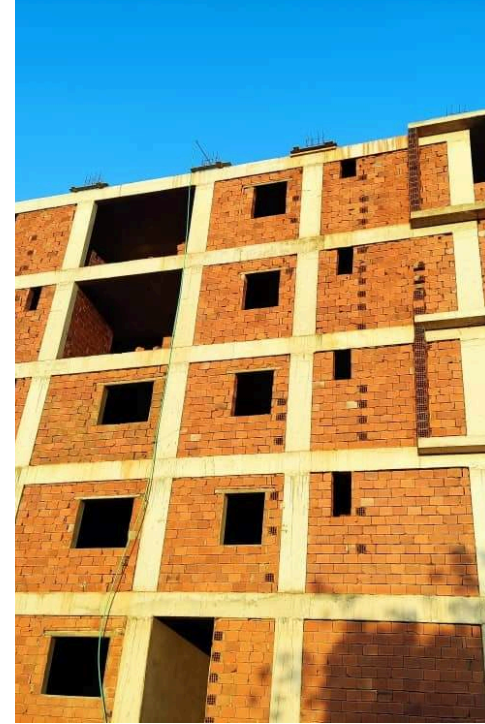
أعمال المباني يكامل الارتفاع
