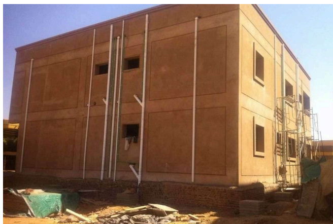
أعمال المباني والتشطيب الخارجي
