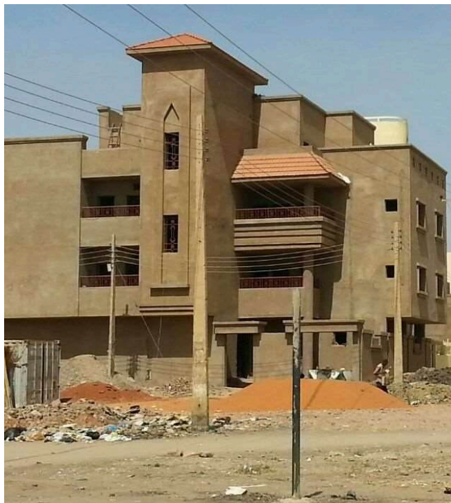
أعمال المباني والبياض الخارجي
