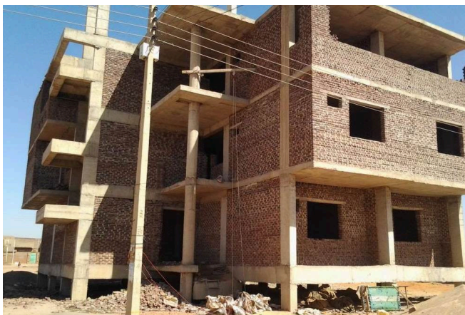
أعمال المباني بالطوب
