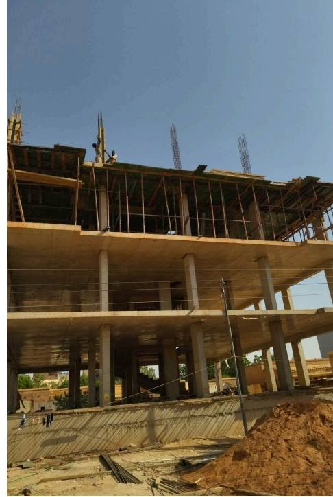
الهيكل الخرساني أثناء التنفيذ
